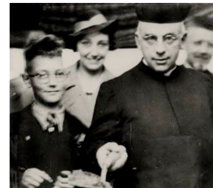
8 september 1938 Eerste steenlegging uitbreiding door pastoor J.M.B. Timp
